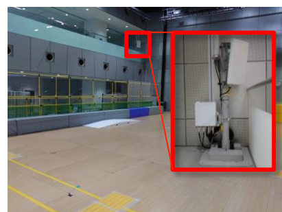
傾斜路走行試験装置エリア
